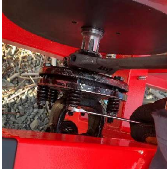
Рисунок 21. Налаштування фрикційної муфти
